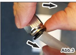
3. Den alten SLS-Schlauch aus dem Steckverbinder am Rohrunterbrecher herausziehen. Dazu den Plastikring zusammendrücken (Abb. 3)
