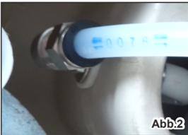
2. WC abmontieren und den alten SLS-Schlauch aus dem Steckverbinder am Winkelstück durch zusammendrücken des Plastikrings herausziehen (Abb. 2)
