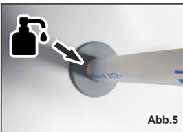
5. Die Dichtung, durch die der alte Schlauch aus dem Spülkasten geführt ist, mit Spül- oder Gleitmittel benetzen, um das durchschieben zu erleichtern (Abb. 5)
